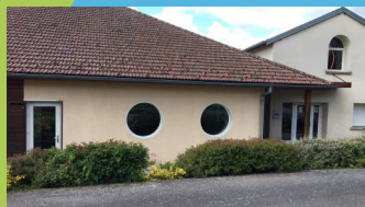
Périscolaire de Lerrain
