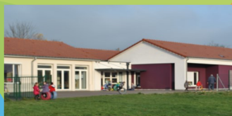
Pole Enfance à Martigny (au groupe scolaire) Accueil de loisirs des vacances
